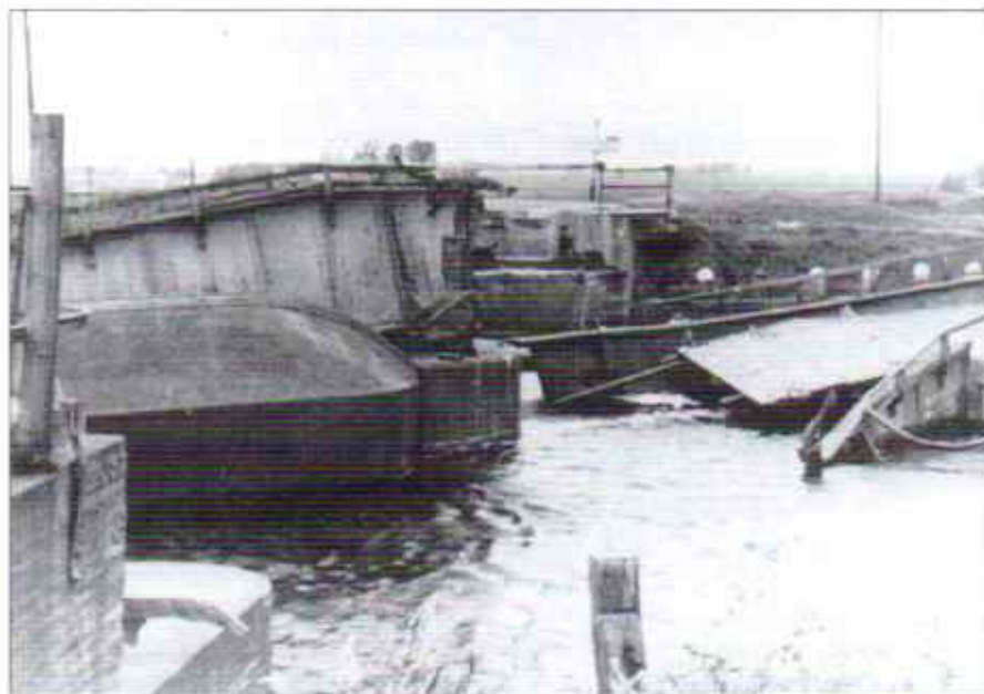
De resten van de Ringvaartbrug. De brug is twee keer kapot gemaakt: een keer beschoten en een keer na aangehangen munitie ontploft. Foto van W. van Dam, foto-archief Stichting Oud Alkemade
